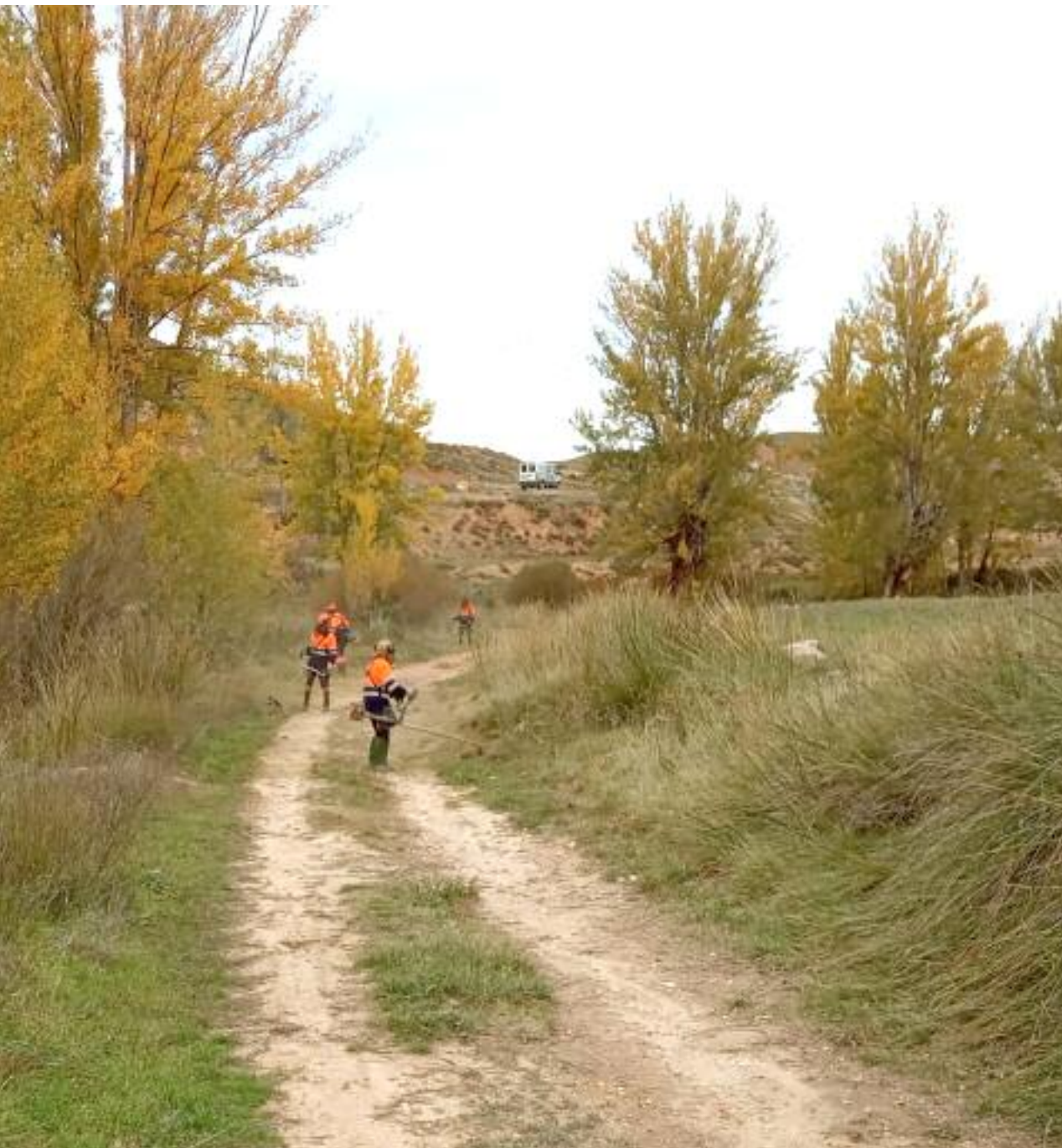
Labores de desbroce de senderos por la brigada comarcal de Cuencas Mineras
